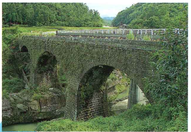
富士見橋 Fujimi Bridge (市指定有形文化財) 橋の上に立つと豊後富士(由布山)が遠くに見えることから、この名がつけられました。この橋は工事半ばに崩落しましたが名棟梁・松田新之助が、意地と信念により私財を投じて完成させたという逸話を持っています。
