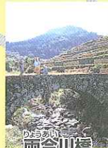
りゅうがわの両合川橋
